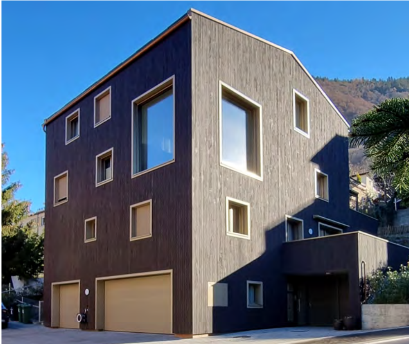
Neubau Zweifamilienhaus in Visp, 2023
